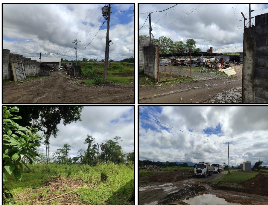
Figura 2. Espacios colindantes al área de construcción de la estación de servicio “Los Almendros”
